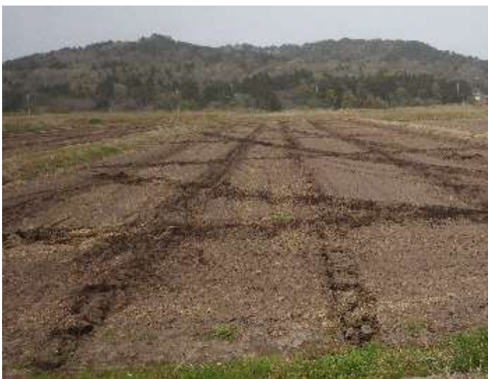
カットブレーカー施工直後の圃場
