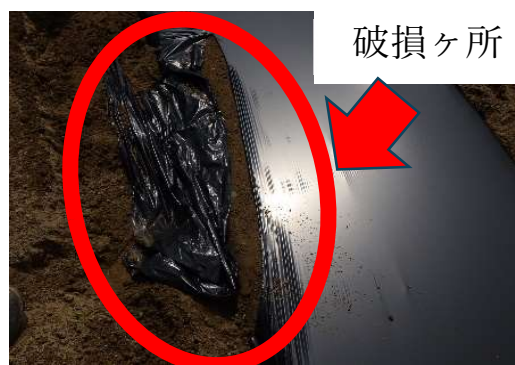
生分解性マルチ設置時の破損
