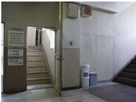
本庁舎と北庁舎の接続部
