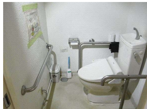
車いす等では入ることが 困難な多目的トイレ
