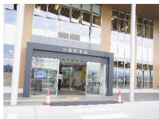
段差のないアクセス (山形県川西町役場)
