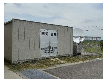
防災倉庫 (会津美里町役場)
