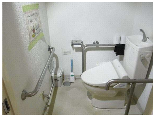
車いす等では入ること 困難な多目的トイレ
