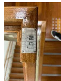
階段手すり点字 (福島県南会津町役場)
