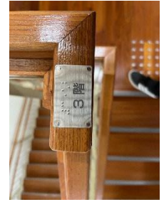
階段手すり点字 (福島県南会津町役場)
