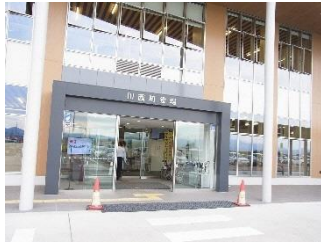
段差のないアクセス (山形県川西町役場)
