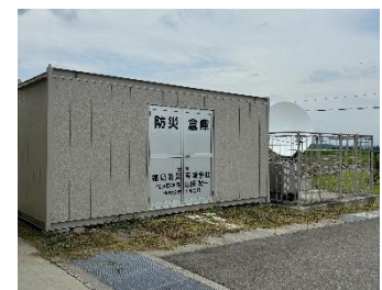
防災倉庫 (会津美里町役場)
