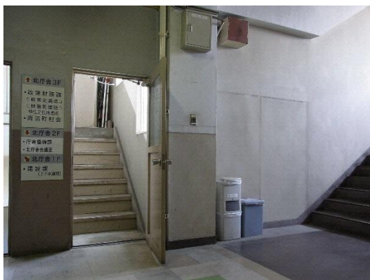
本庁舎と北庁舎の接続部
