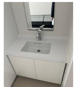
洗面化粧台 (会津若松市役所)
