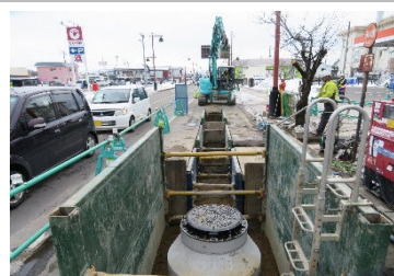
下水道開削工法
