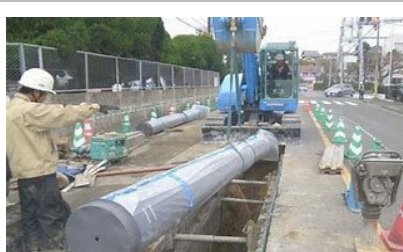
上水道開削工法
