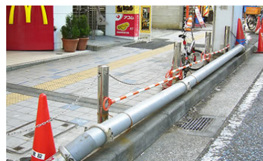
上水道仮設管
