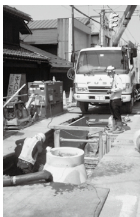
下水道整備工事
