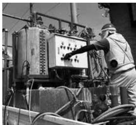
◀トラックの荷台に設置した機械から管を通して薬液を送る
