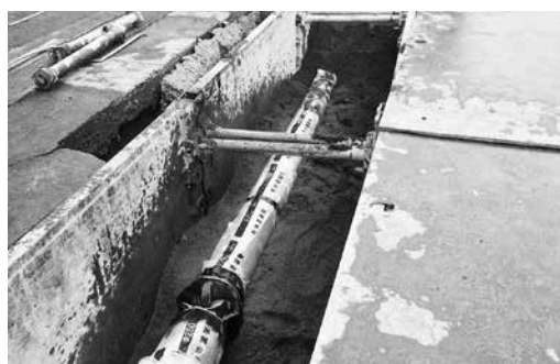
▲道路から85cm掘った高さに配水管を設置
