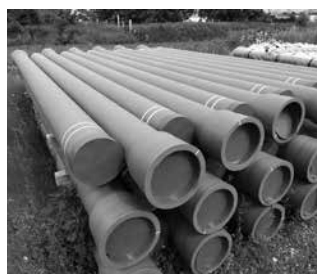
▲保護材をする前の状態
