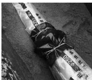
▲宅内までの管をつけて
