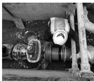
▲新しい地下式消火栓を設置
