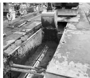
▲砂で埋めて設置工事完了 水道水を届ける
