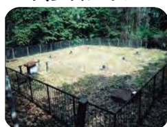
けたのみや 気多宮 配水池
