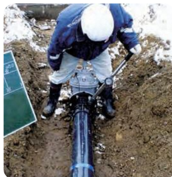
水道管を交かんしているところ
