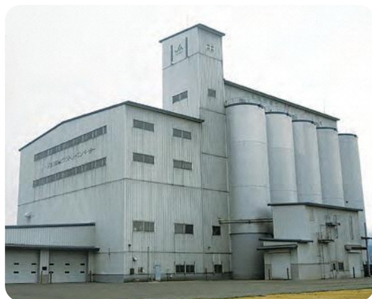
カントリーエレベーター
