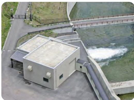
発電所の建屋
