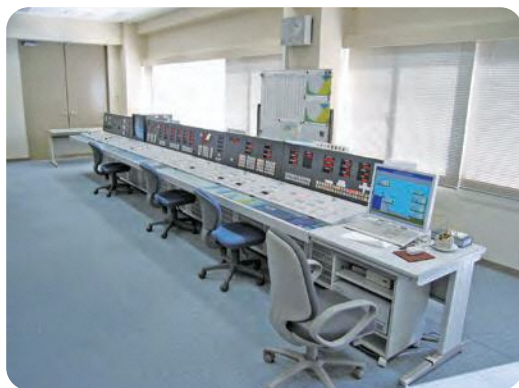
ダムの管理施設
