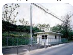
とうでら 塔寺 ポンプ場
