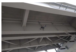
ドローンによる桁下の点検
