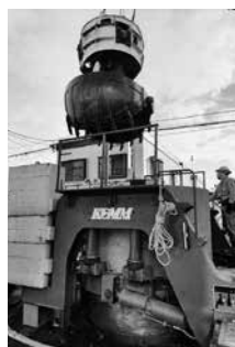
▲穴(立坑)の掘削
