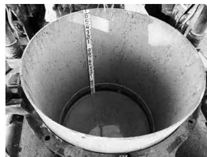
▲穴(立坑)を掘り終わった様子
