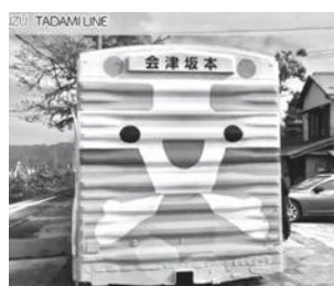
全国的に珍しい「ワラ1形有蓋貨車」を再利用した会津坂本駅の駅舎
