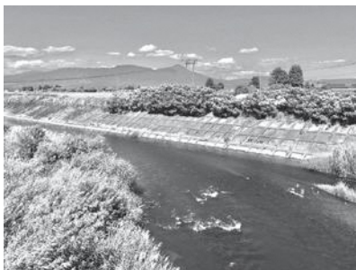
2015年に氾濫した宮川と 浸水した細工名地区
