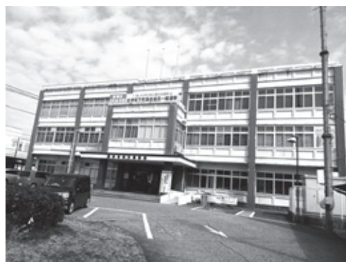
現庁舎の耐震性は？
