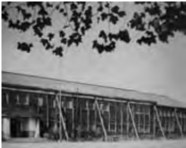
友禮氏の寄附により移転増改築された八幡小学校 (八幡小学校・八幡幼稚園閉校閉園記念誌より引用)
