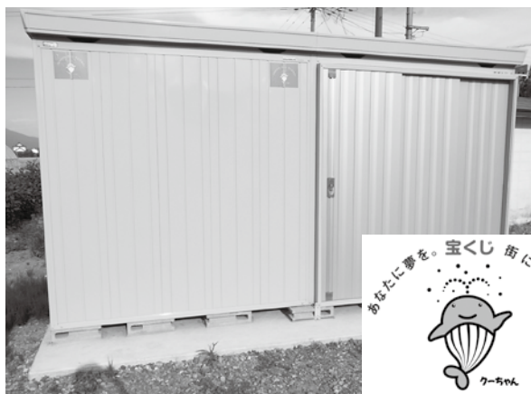
▲防災備品を格納する倉庫
