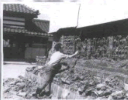
▲昭和39年に発生した新潟地震による会津坂下町の被害 被害総額（当時のお金で）1億8千万円を突破した
