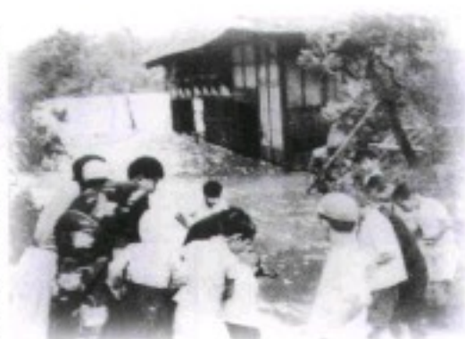
▲昭和33年頃 洪水の被害にあった大阪屋
