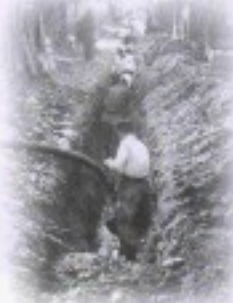
▲昭和38年頃の配水 管布設工事の様子
