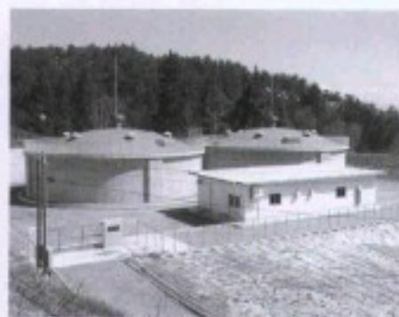
▲牛沢地区にある中央配水場
