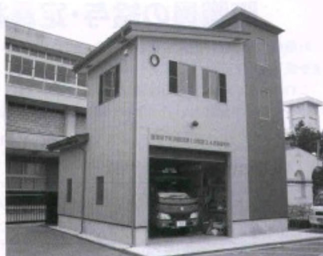
新しいポンプ車も配備された第一分団三・四班屯所 (消防施設整備事業)
