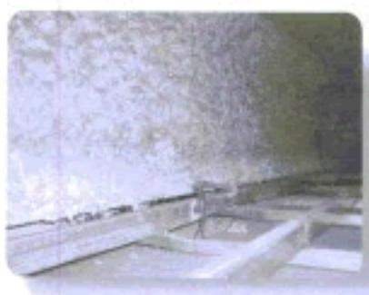
天井裏断熱のための吹き付けアスベストの状況
