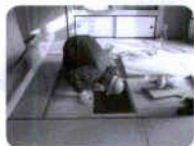
耐震診断状況 (基礎の状況 を調べている ところ)
