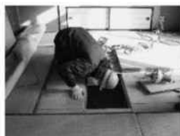
耐震診断状況（基礎の状況を確認している様子）
