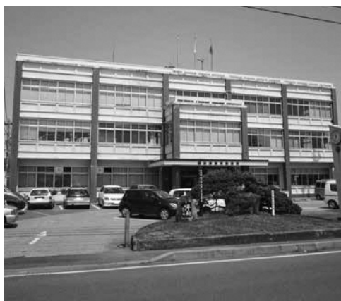
建て替えを待つ現庁舎
