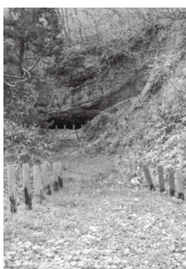
現在は通行できない 東松洞門
