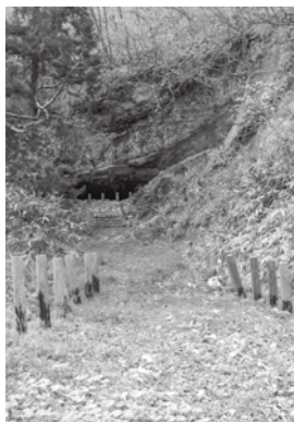
現在は通行できない東松洞門
