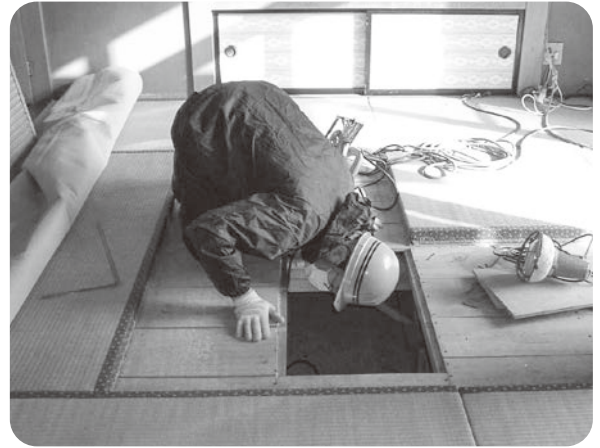
【耐震診断・基礎の確認状況】
