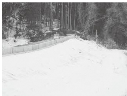
竣工した只見川堤防かさ上げ工事
