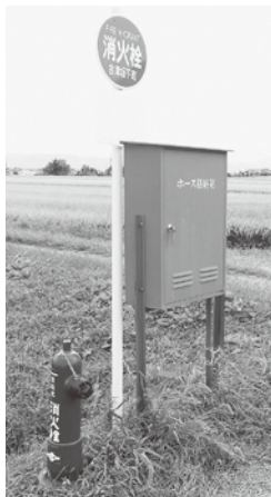
各所に設置してある消火栓
