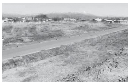
原野化し、土砂の仮置き場の県有地
