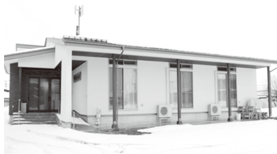
▲新設された新町自治会コミュニティセンター
