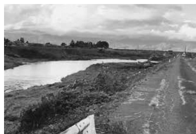
掘削工事が進められている宮川(細工名付近)
