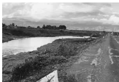
掘削工事が進められている宮川（細工名付近）
