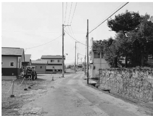
早急な安全対策が望まれる原街道
