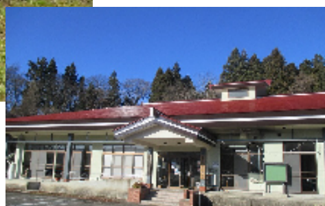
高寺地区コミュニティセンター
