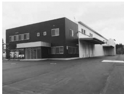
坂本工業団地に新設された第2工場
