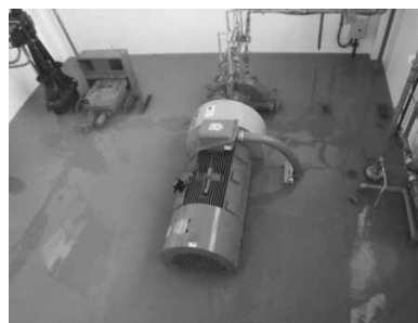
災害を受けた揚水機（袋原区）
