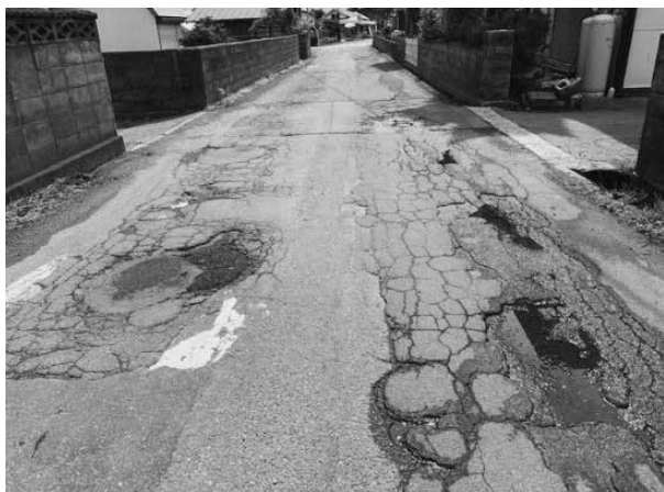
補修されず劣化が進む幹線道（牛沢）
