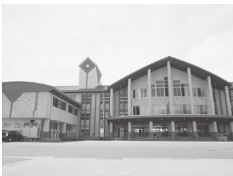
エアコンの設置工事が 始まる坂下中学校
