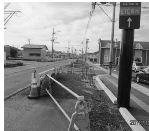
早期完成が望まれる緑町交差点
