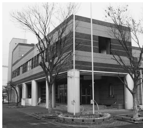
庁舎代替施設となる中央公民館
