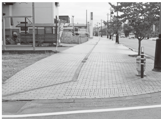
地区計画により広く整備された歩道
