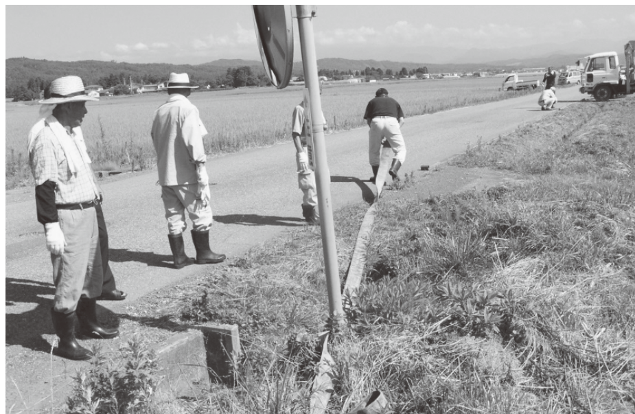
住民による渇水対策のポンプ送水作業（牛沢区）
