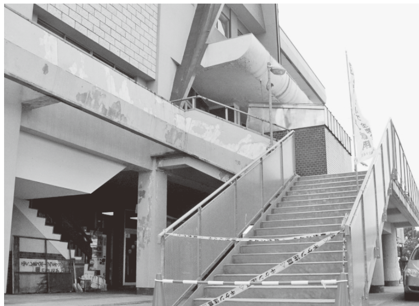
町民体育館の除却決定により解体費も財政を圧迫
