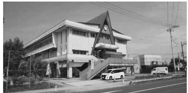
撤去される会津坂下町民体育館
