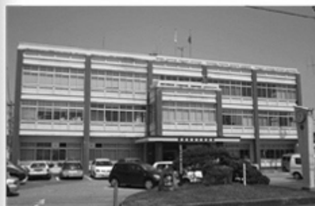
56年が経過した現庁舎
