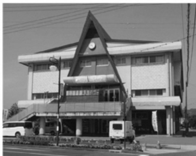
老朽化した町民体育館
