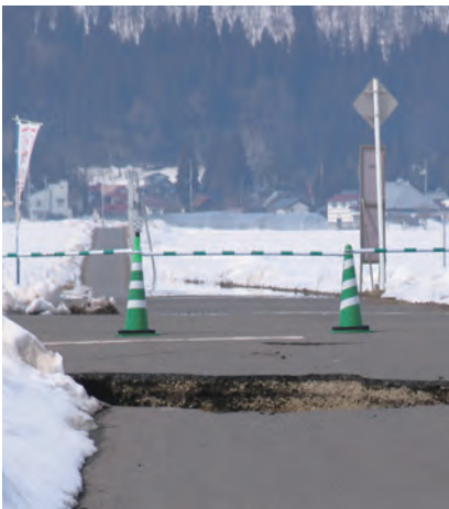
寸断され通行できなくなった道路（樋渡）
