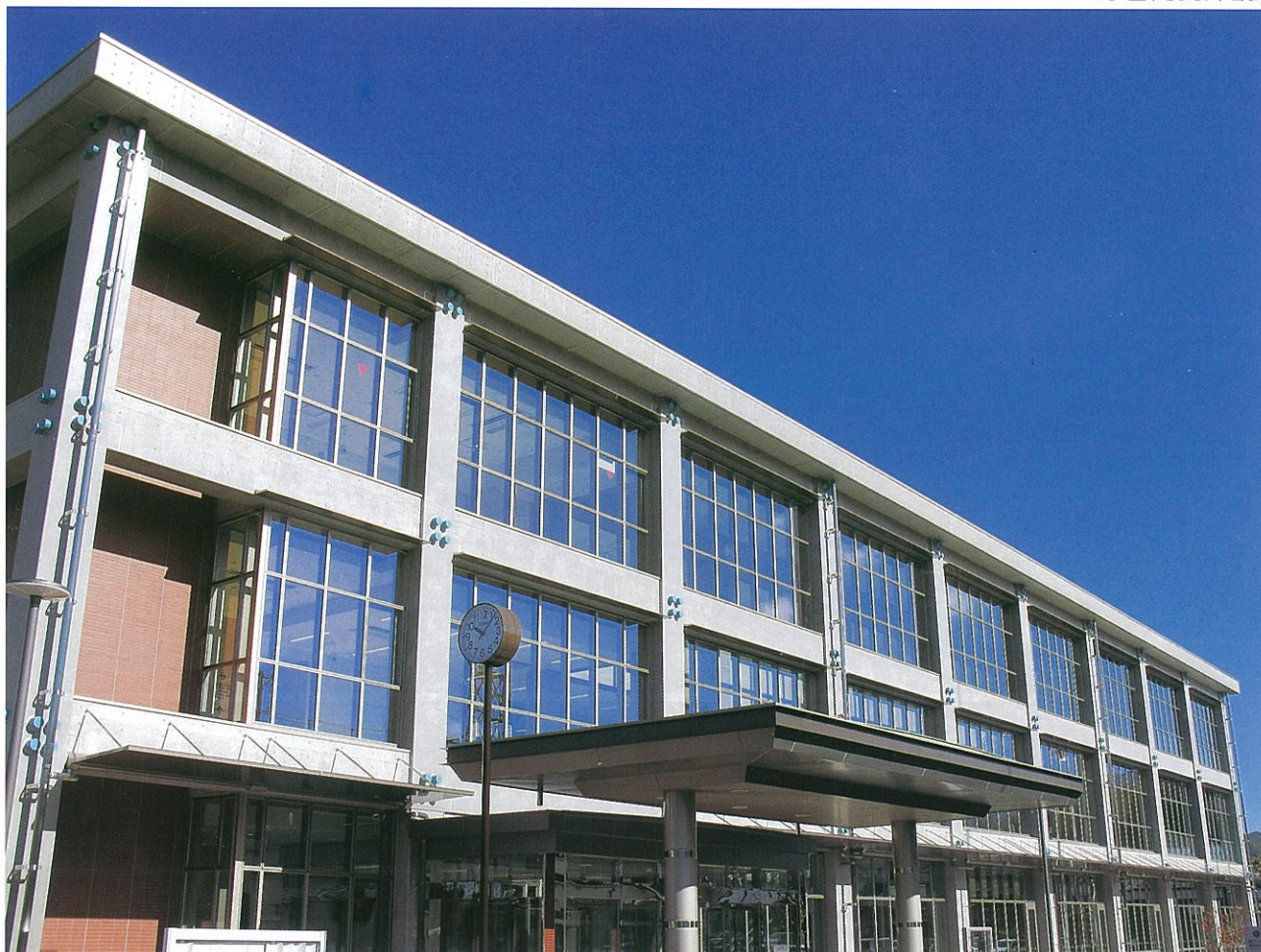
(庁舎南側外観)
