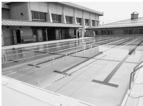
坂下南小学校プール
