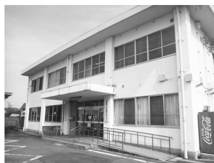
会津坂下町保健福祉センター
