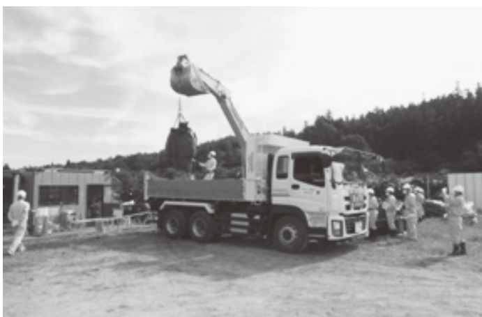
大型土のうの積み込みの様子
