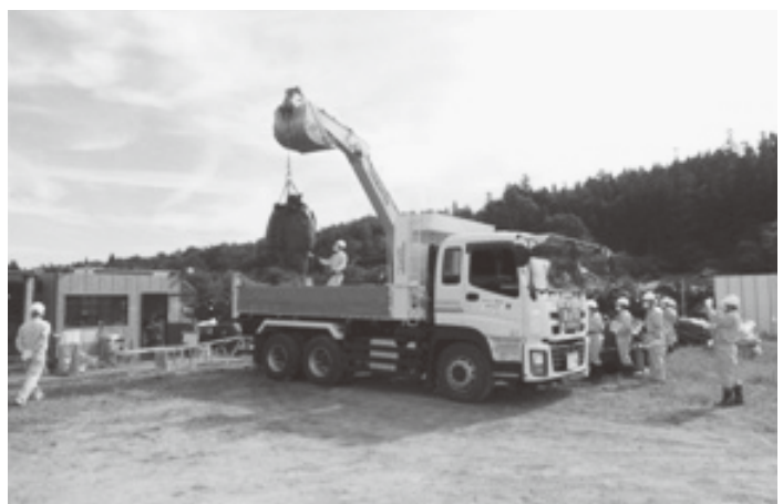
大型土のうの積み込みの様子
