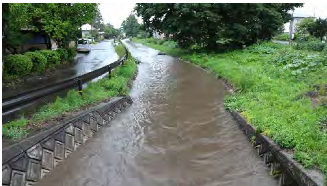
栗村水路（原地内）
